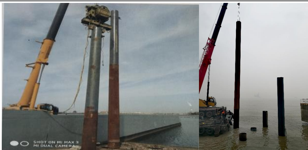
图 1.6-1 钢管桩打桩施工示意图
