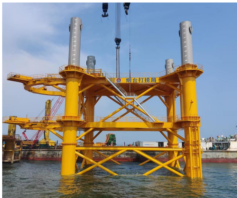
图 1.6-3 稳桩平台辅助桩沉桩
