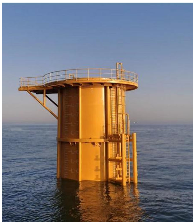
图 1.5-1 单桩基础方案图
