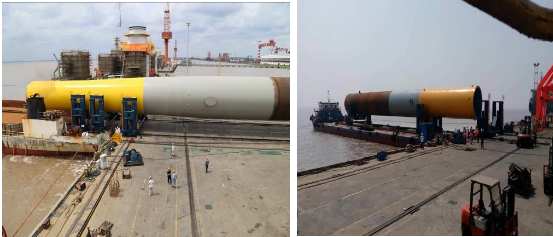
图 1.5-5 单桩出运桩驳
