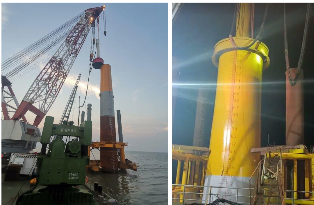
图 1.5-6 单桩沉桩示意图
